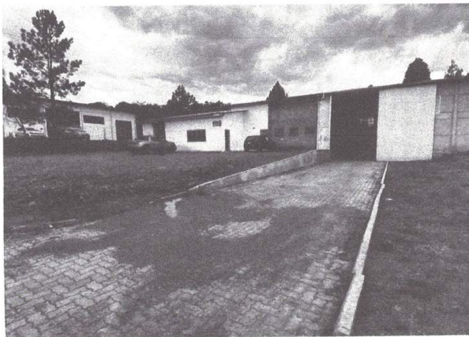
Figura 8 - Vista Terrenos 05 e 06
