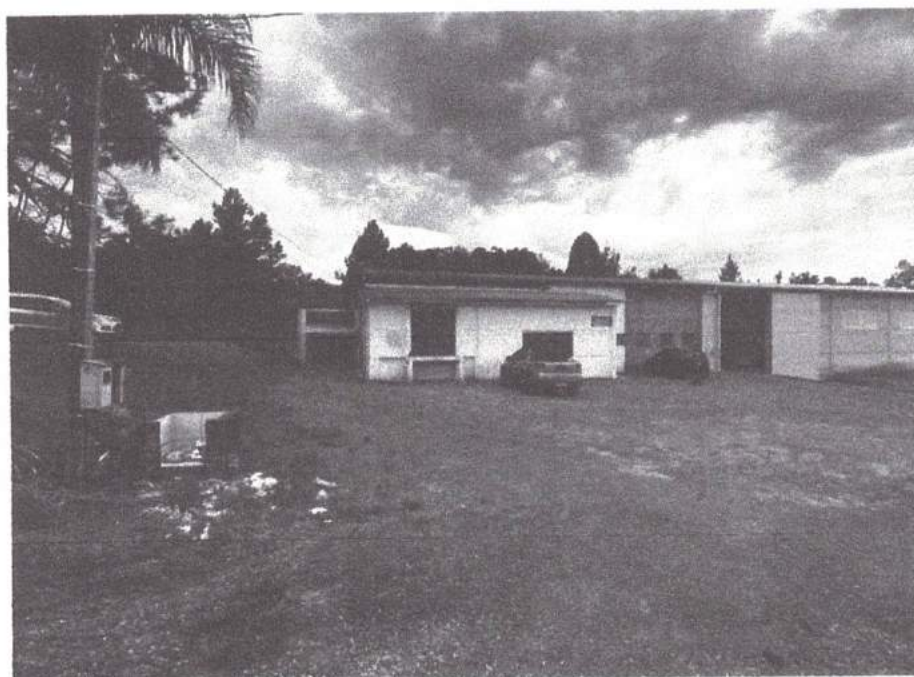
Figura 4 – Vista Terrenos 05 e 06
