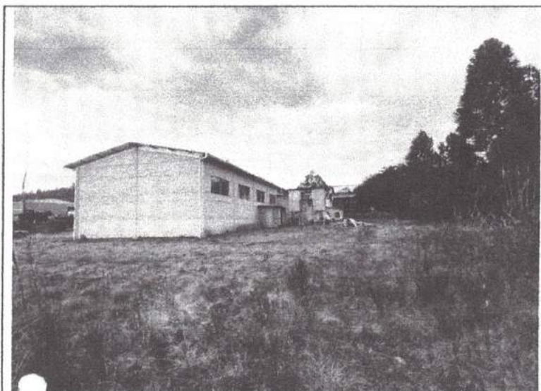
Foto 09 - Parte de trás do terreno
