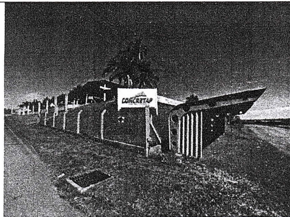
02 - Vista lateral, área de esquina, com asfalto a parada de ônibus.
