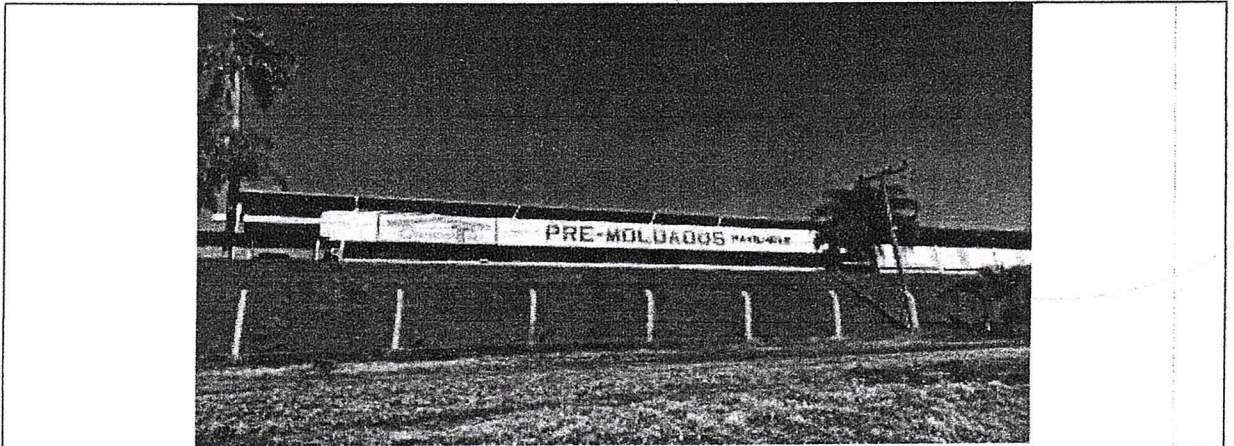
01 – Vista frontal da área do avaliando vista pela ERS – Este pavilhão não é a benfeitoria avaliada.
